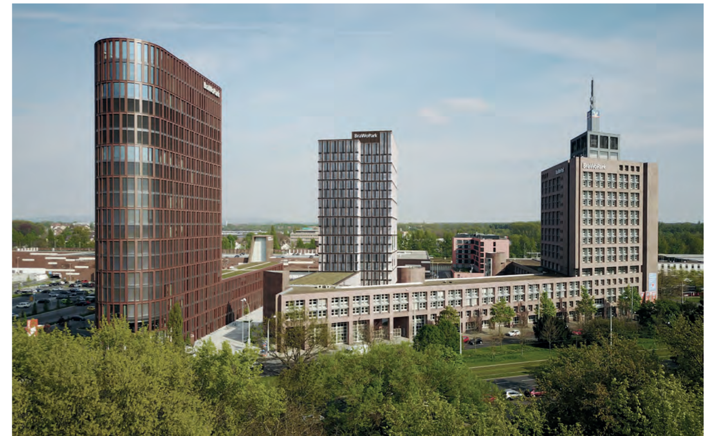
Businesscenter III: Der Neubau in der Mitte komplettiert den Braunschweiger BraWoPark (rechts BC I, links BC II). Die Fassade des Neubaus fügt sich mit ihren dunkelrot/braunen Elementen in das Farbkonzept der Bestandsgebäude ein Abb.: STAUTH Architekten/cube visualisierungen
